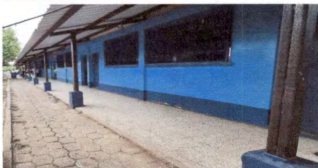
Foto 1: Sustrución de estructura de soporte de metal, por metal, modulo 2
