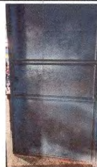
Foto 6: Mantenimiento a estructura (lijado, cambio de tubo , cepillado, sujeciones, aplicación de pintura) Modulo 3
