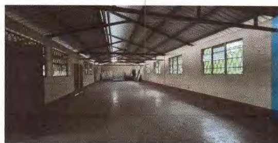
Foto 12: Pintura en muros interiores
