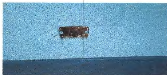
Foto 10: Instalación de unidades fuerza (tomacorriente), incluye cable eléctrico
