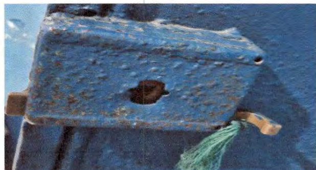
Foto 2: Sustrución de chapa, modulo 2
