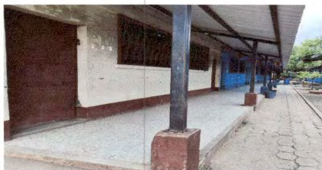
Foto 4: Sustrución de estructura de soporte de metal, por metal, modulo 3
