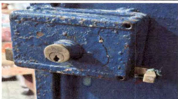
Foto 5: Sustrución de chapa, modulo 3
