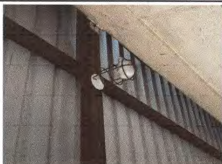
Foto 9: Sustrucción de focos ahorradores, instalación de unidades luz (incluye interruptor, ducto y cable eléctrico)
