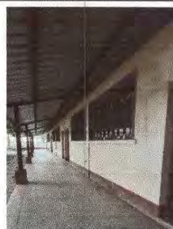
Foto 8: Sustrucción de estructura de soporte de metal, por metal, salón
