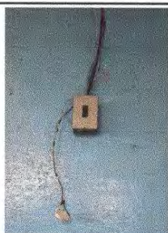
Foto 11: Sustrucción de tablero de flipones, sustrucción de flipon
